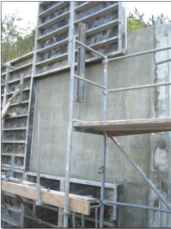
Bild V. Ausschalvorgang einer Innenwand
