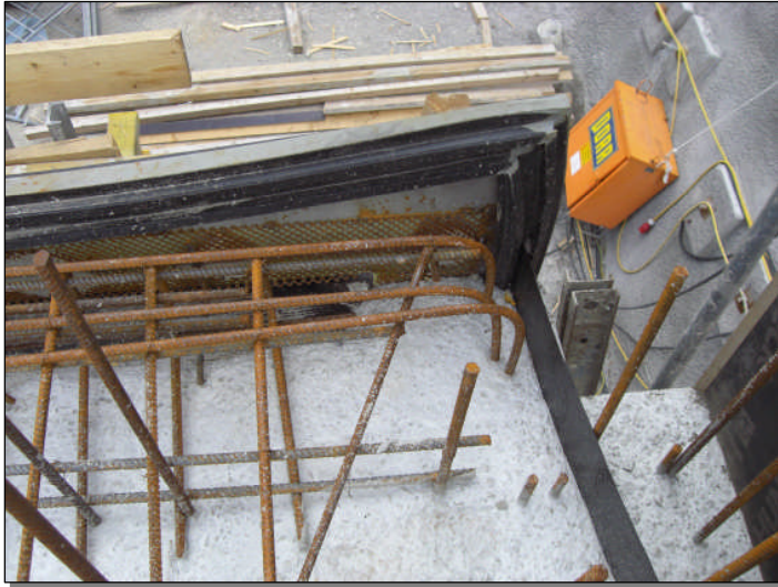
Bild XIII. Beschichtetes Fugenblech
