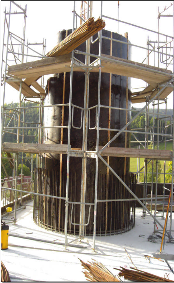
Bild VI. Ansicht Innenschalhaut Lüfterturmwand
