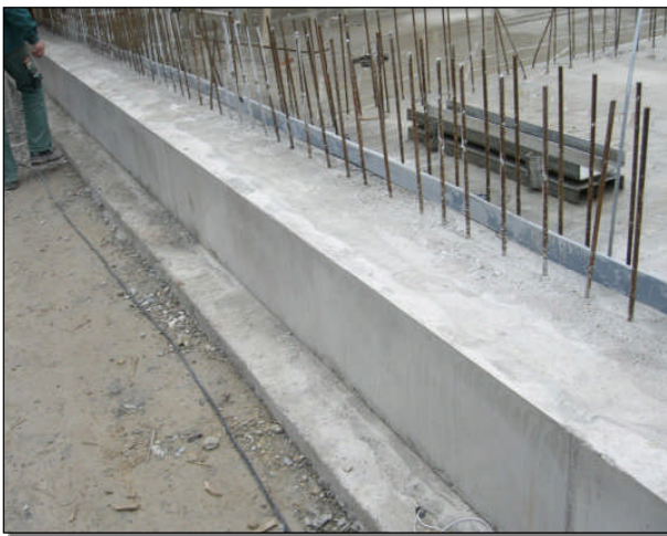
Bild XI. Anschluss mit Fugenblech
