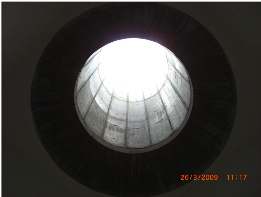
Bild XVIII. Innenansicht Lüfterturm nach Fertigstellung
