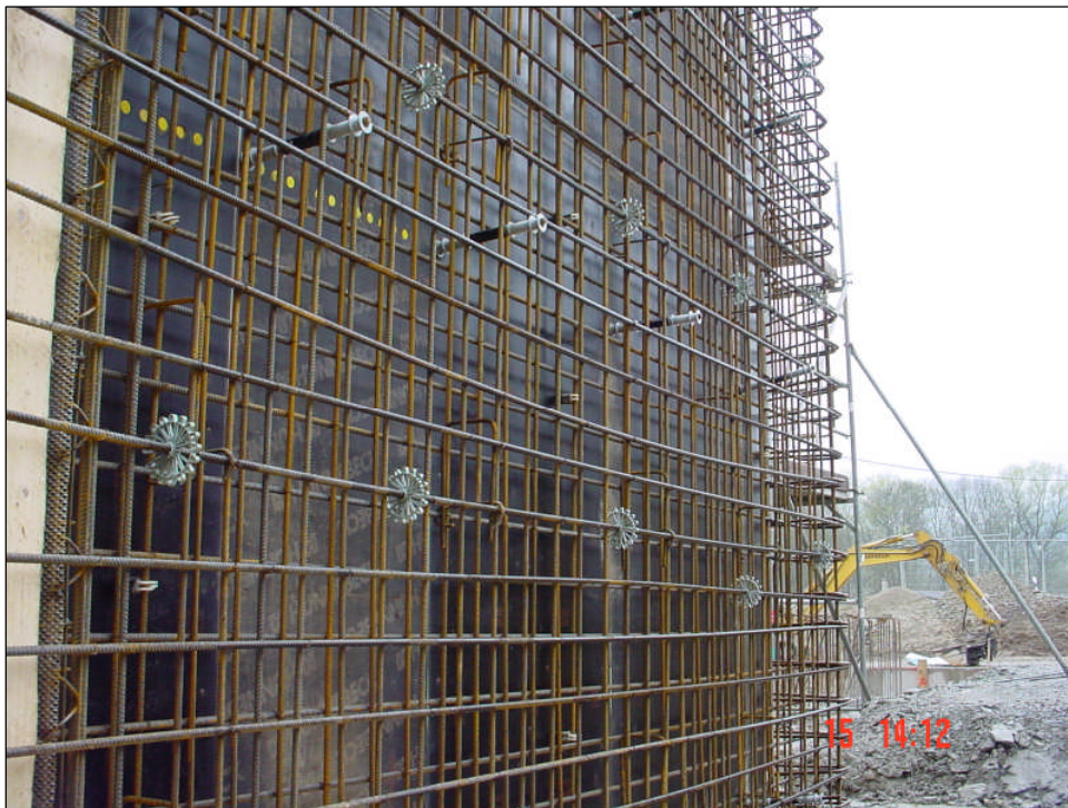
Bild XVII. Hüllrohre für Ankerstäbe der Rahmentafel
