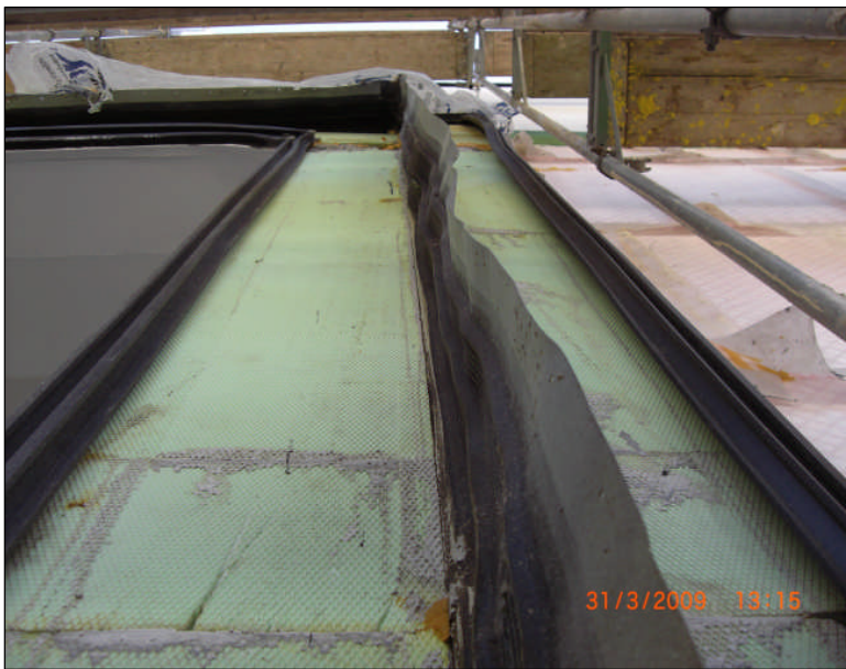
Bild XIV. Umlaufendes Fugenband aus Elastomer
