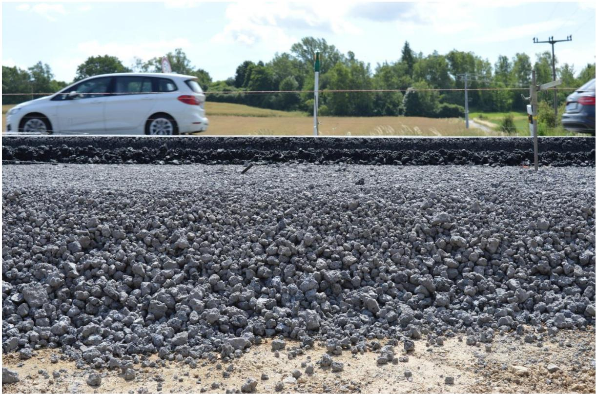
Elektroofenschlacke unter Asphalt
