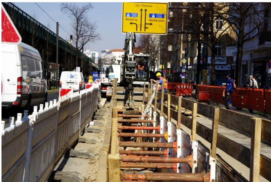
Abbildung 16: Großer Platzbedarf bei dem Austausch einer Bestandsleitung
