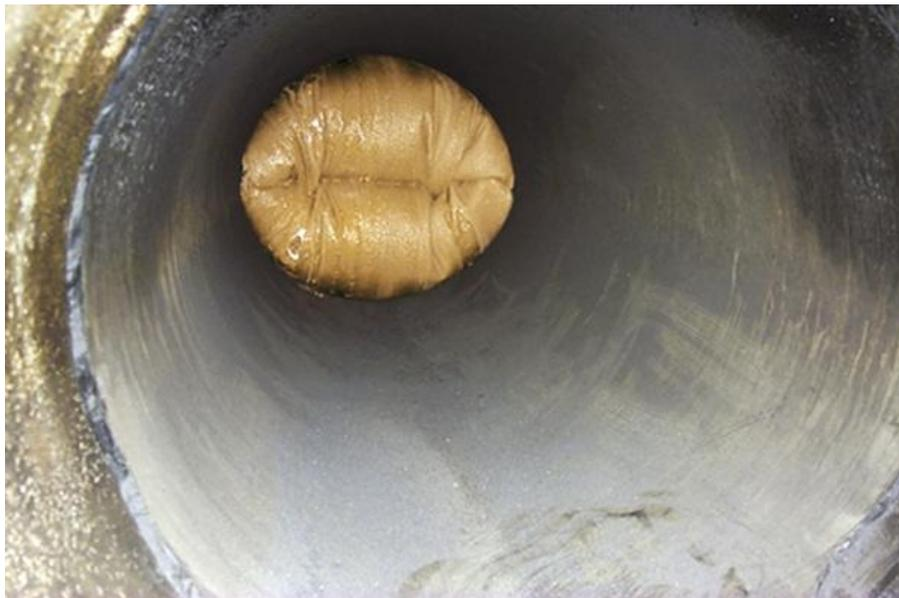
Abbildung 19: Einbringen des Schlauchinliners mittels Reversionsverfahren
