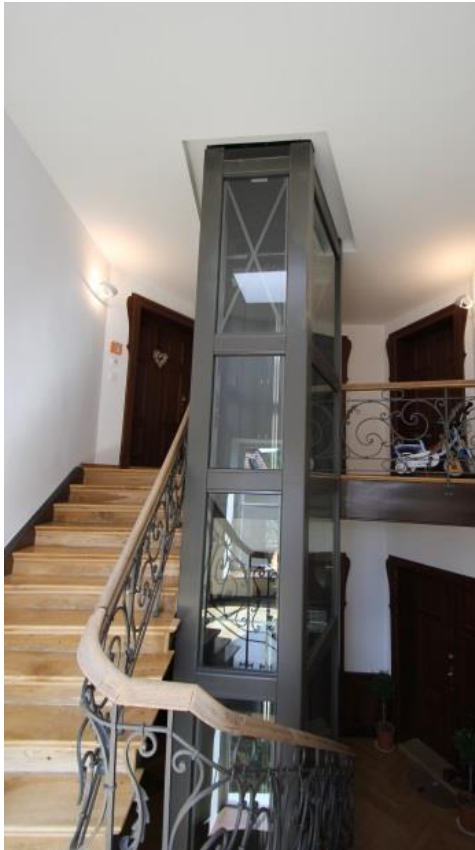
Abb. 2 individueller Aufzugsschacht im Treppenauge eines Wohnhauses
