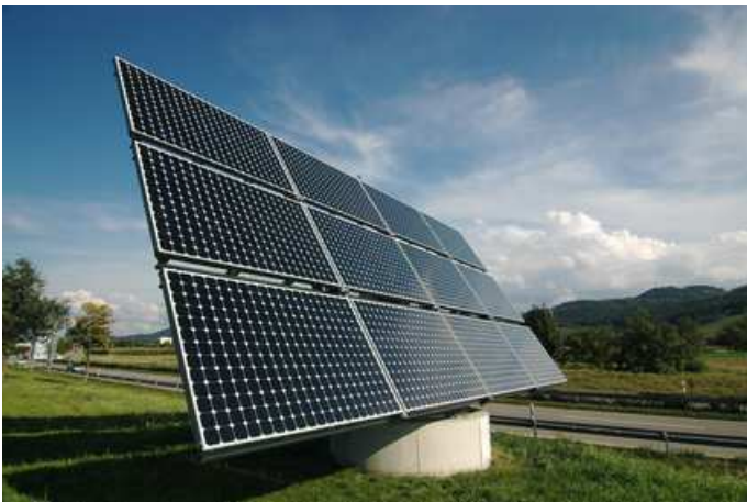
Abb. 12: Beispiel einer nachgeführten Anlage
