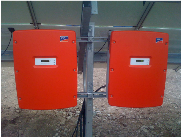
Abb. 10: 2 von 72 Stringwechselrichter STP 17000 von SMA im Projekt Erfurt Ost von AIC PROJECTS
