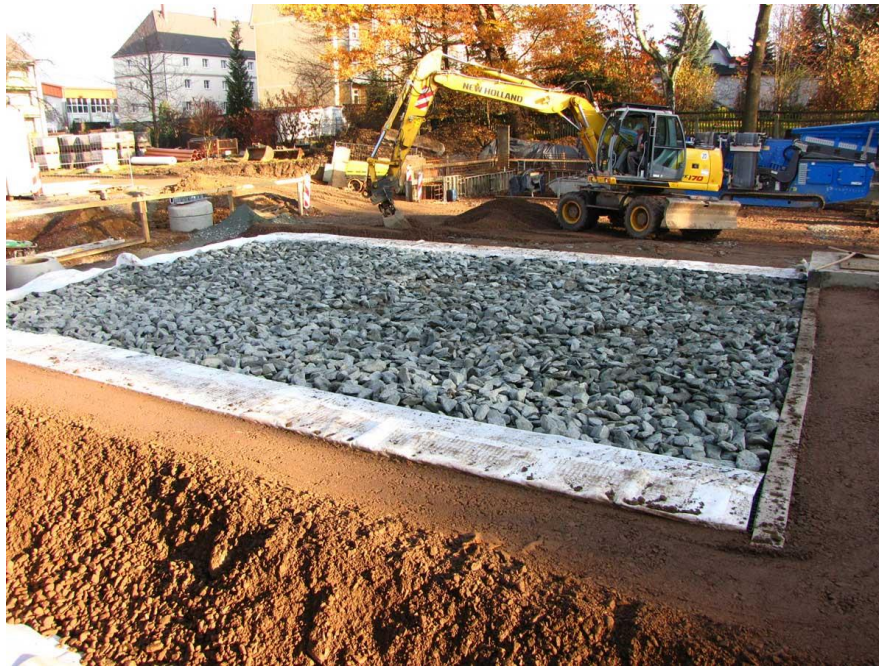
Abbildung 4 Schotterspeicher unterhalb der Bodenplatte ( https://www.ibfht.de/schotterspeicher , 02.07.2025)
