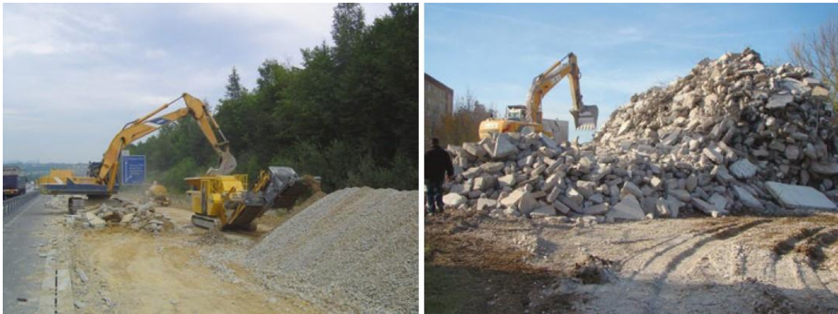
Abbildung 12 Betonaufbruch beim Abbruch einer alten Fahrbahndecke (links) und Betonabbruch beim Rückbau eines Mehrfamilienhauses in Plattenbauweise (rechts) (MÜLLER, 2018, S. 178)
