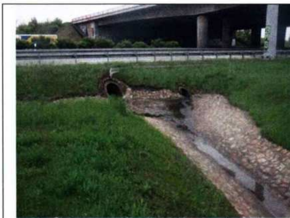
Sanierter Durchlaßbereich aus der B100
