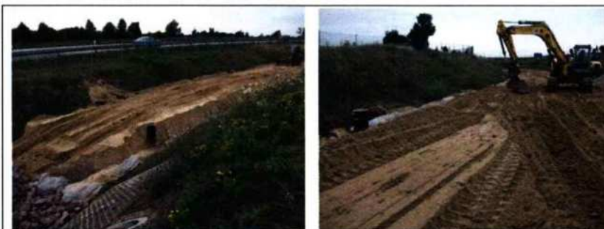
Sohlanhebung Becken 650 mit Einbau Böschungsrohrigole DN 100
