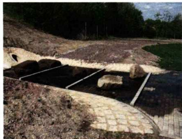
Auslaufbereich zum neuen Bodenfilter
