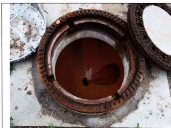
Blick in den Wirbelschacht von oben
