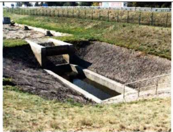
Aufreinigung des Absetzbeckens
