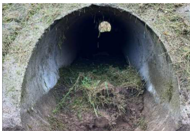
Abbildung 15 Ablagerungen im Zulauf Becken 649
