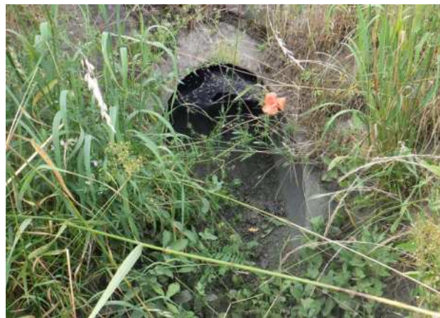
Abbildung 16 Verschmutzung des Zulaufs des Absetzbeckens 614
