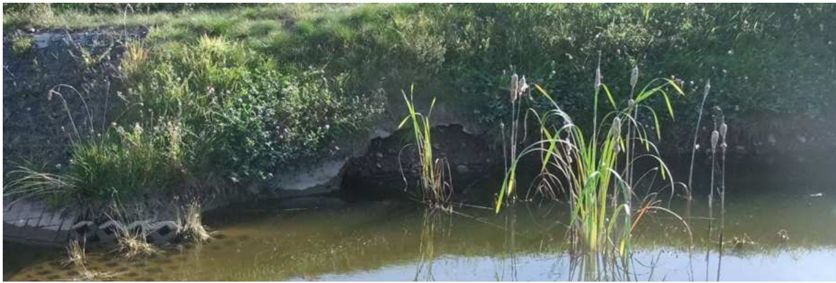
Abbildung 14 Ausbrüche am Becken 928
