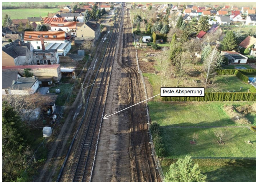
Abbildung 3 Km 72,600 Glaubitz, Bauphase 1 Drohnenaufnahme, interne Unterlagen
